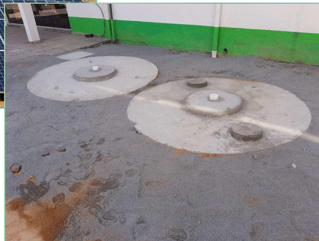
Obra de Tanque e Filtro Séptico =R$22.732,00 Campus Blumenau- 100,00% Concluída
