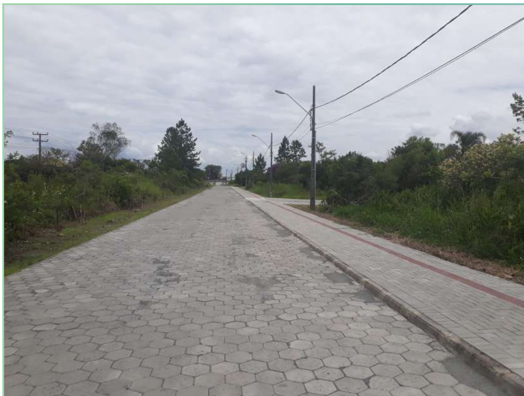
Obra de Pavimentação=R$836.014,21 Campus Araquari – 100,00% Concluída
