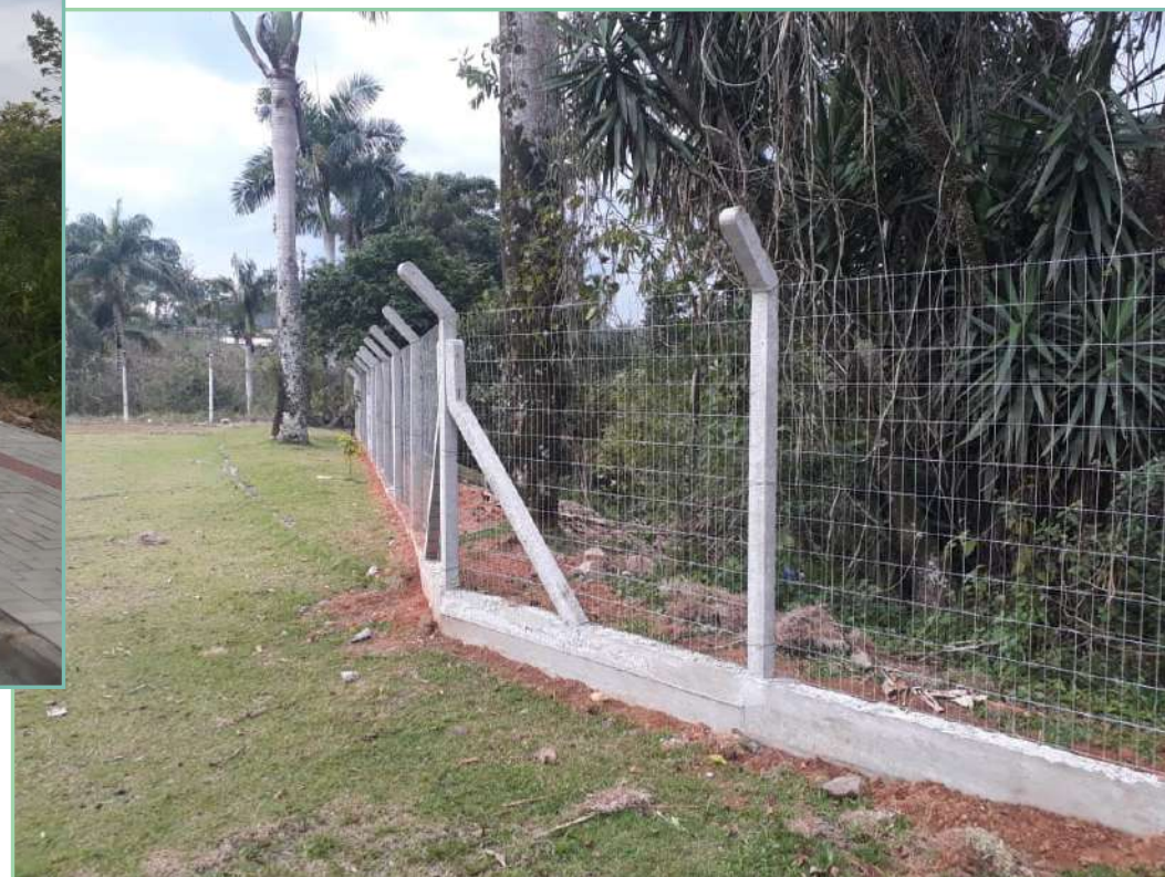
Obra de Conserto e Construção de Cerca=R$73.941,15 Campus Blumenau – 100,00% Concluída
