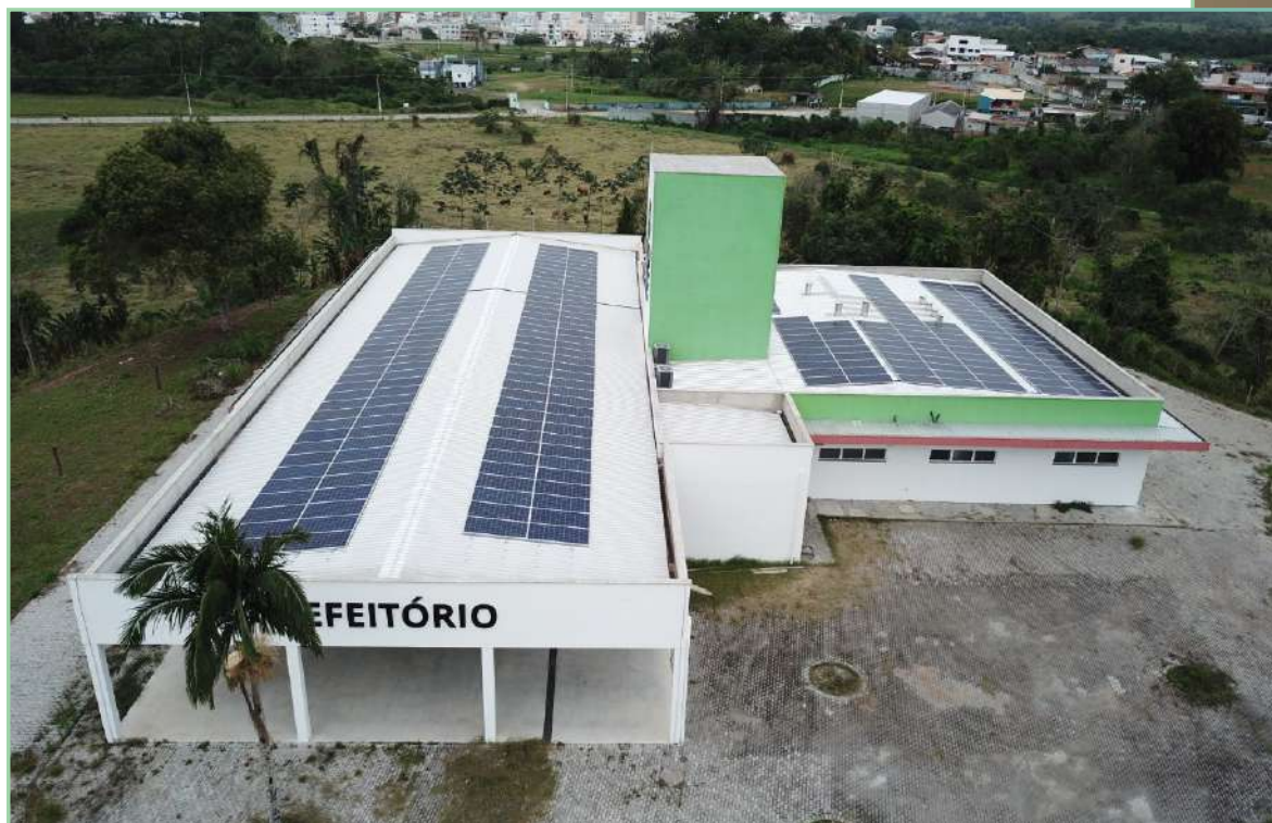
Obra de PPCI=R$239.122,77 – Campus SRS 100,00% Concluída ▼
