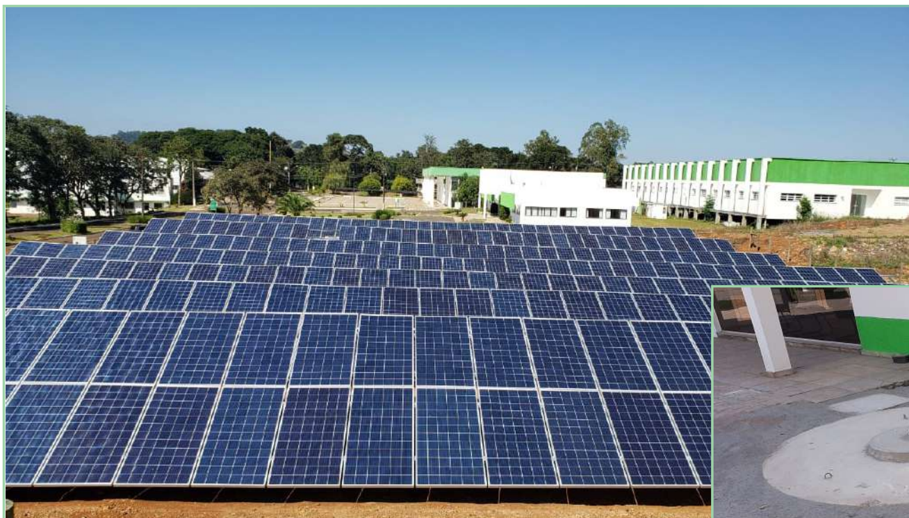
Obra de USF =R$R$637.679,40- Campus Concórdia 88,00% Concluída
